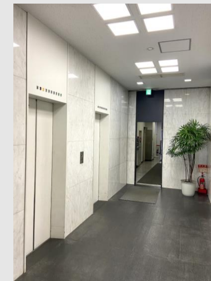
1階 EVホール
